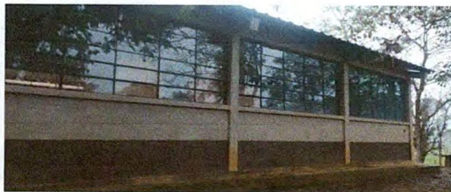
Foto 1: Aula Multigrado de segundo, tercero, cuarto, quinto y sexto. Mantenimiento estructura metálica de ventanas y puertas.
