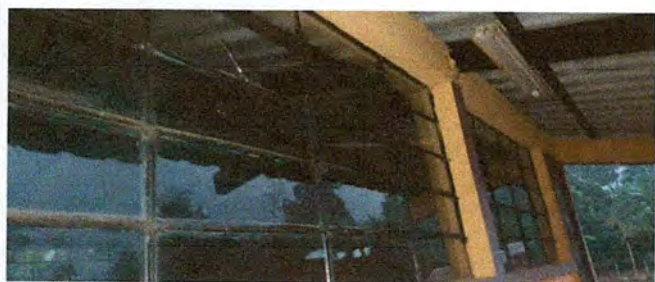
Foto 3: Reparación de sistema eléctrico de Aula Multigrado de segundo, tercero, cuarto, quinto y sexto.
