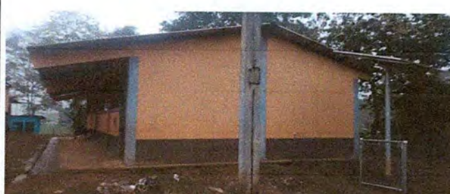
Foto 4: mantenimiento de muros interiores y exteriores.
